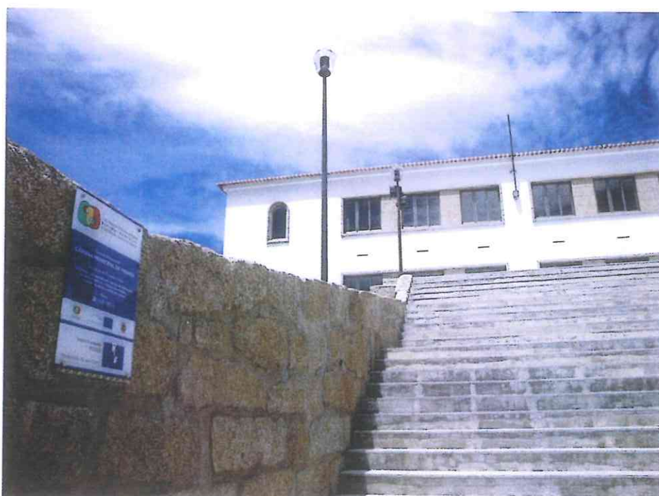
CENTRO DE APOIO A EMPRESAS LOCAIS
