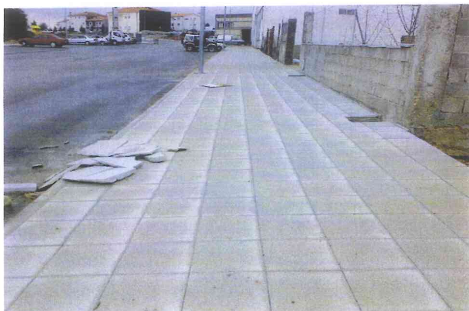
Foto 3 –Arruamento – colocação de Mosaicos
